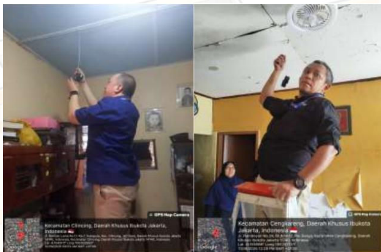
Gambar 14 Pemasangan Detektor Radon di Salah Satu Rumah Warga di wilayah Jakarta
