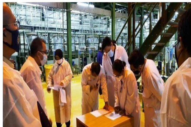
Gambar 1.6 Instalasi Elemen Bakar Eksperimental
